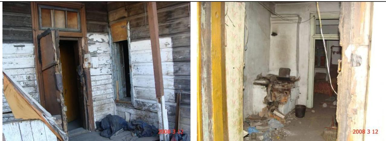
Два оконных проема в середине основного объема закрыты ставнями, с поврежденными филенками. В 3-ем проеме отсутствует остекление. При осмотре дворового фасада выявлено, что дверь входа на северо-западном фасаде дворового объема, ведущая в квартиру, расположенную в середине основного объема, раскрыта. Открытое помещение не эксплуатируется, печь разобрана, оконная рама на дворовом фасаде утрачена. В оконных рамах на главном фасаде остекление с повреждениями.
